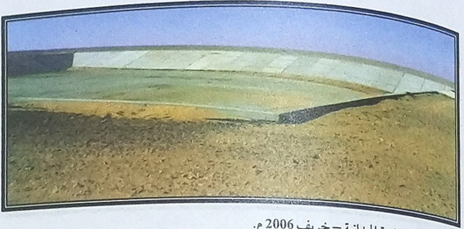
صورة رقم ( 34 ) خزان سطحي مكشوف - جنوب بوهادي.
