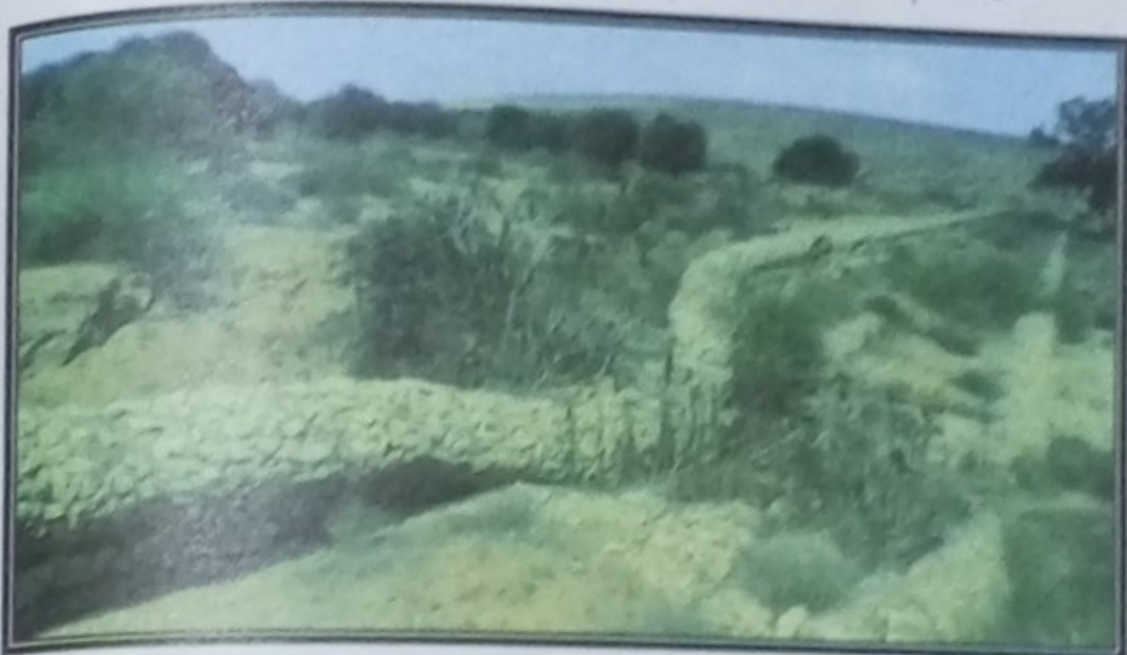
صورة رقم ( 6 ) سد دعويقي محطم بفعل السيول والفيضانات - وادي الحنيوة.
