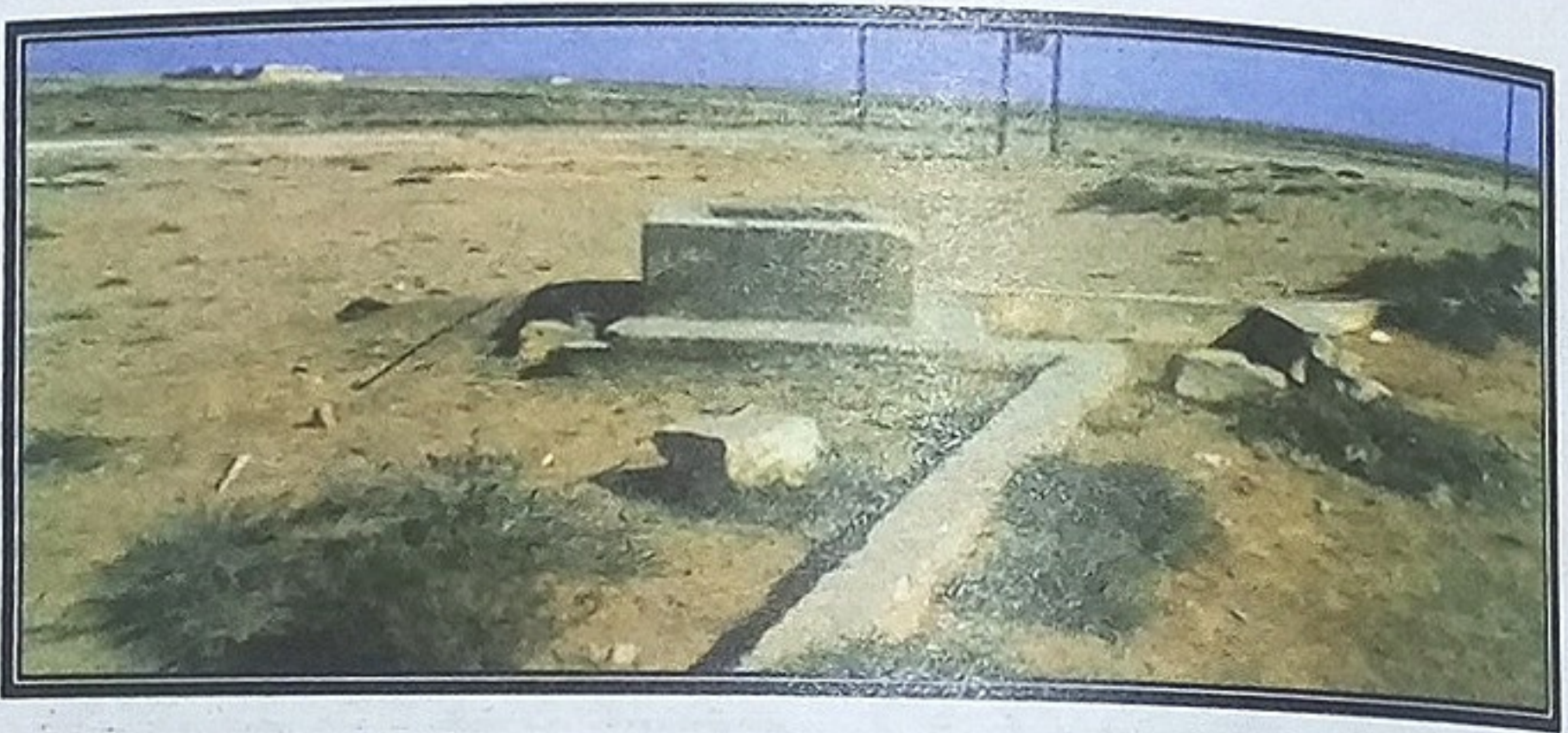
صورة رقم ( 35 ) ماجن لتجميع مياه الأمطار - وادي جارف.
