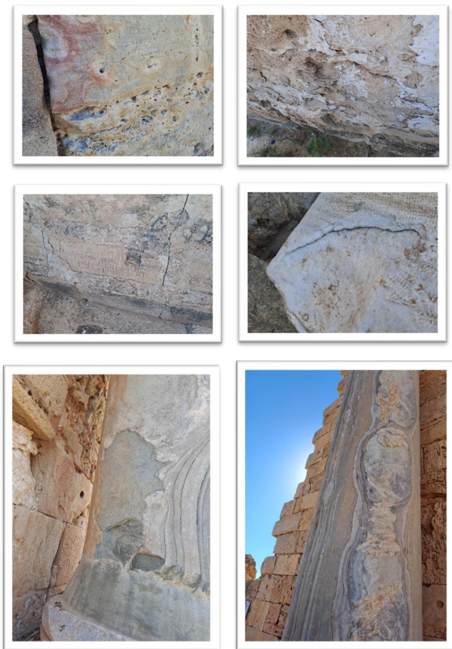
شكل 2: بعض الصور تبين تأثير التجوية الكيميائية على صخور مدينة لبة
