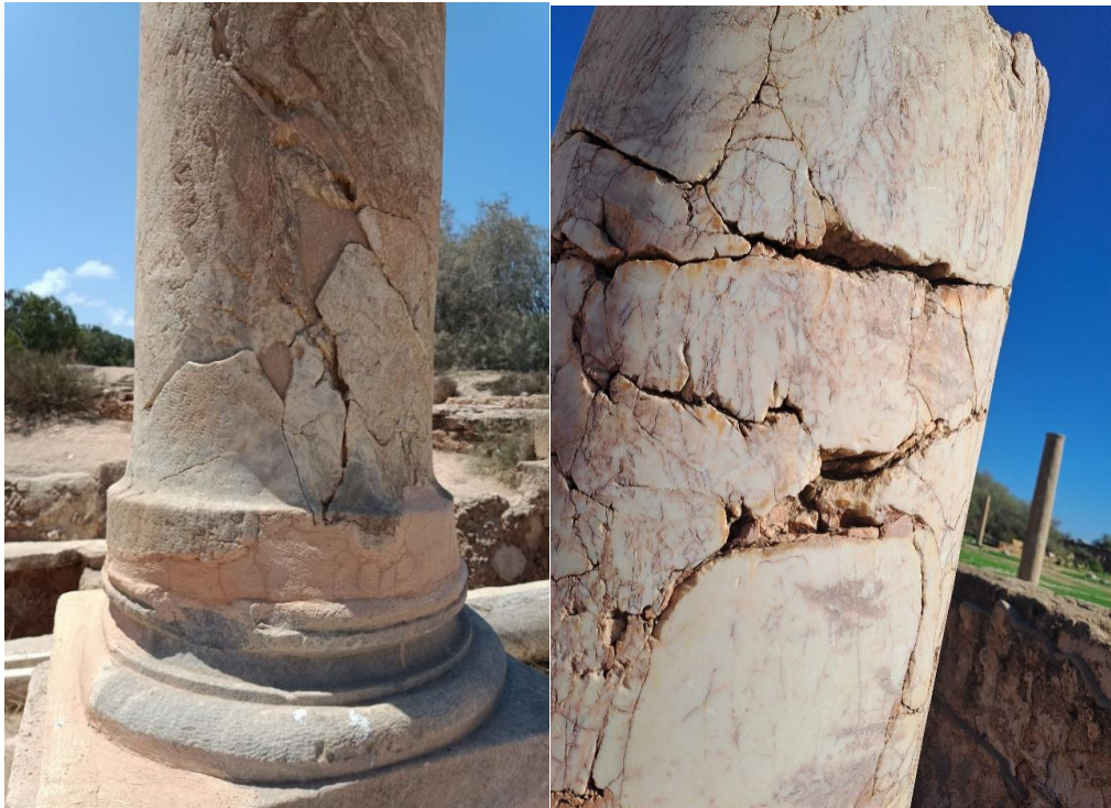
شكل 11: صورتين تبين ظاهرة تقشر عن طريق التعرض المتكرر للتغيرات الحرارية
