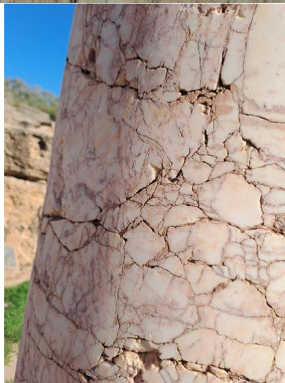
شكل 12: صورتين تبين ظاهرة تشقق عن طريق التعرض لبعض الضغوط الميكانيكية أو التخلخل الحراري
